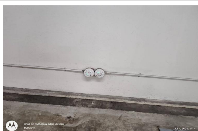
รูปที่ 3.8-10 เครื่องตรวจจับแก๊ส (Gas Detector)
