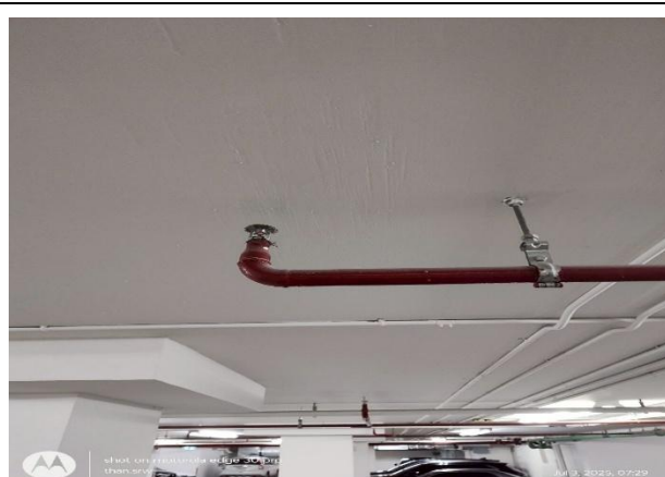
รูปที่ 3.8-9 ระบบหัวสปริงเกอร์ดับเพลิงที่ลานจอดรถ
